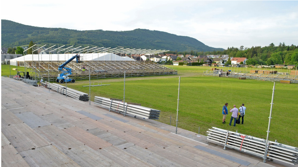
In Aarau Rohr entsteht eine Schwingerarena für 5500 Zuschauer. (Foto: wr)
